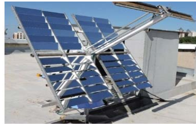
Жылу және электр энергиясын алуға арналған автономды күн қондырғысы
