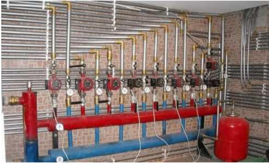
Сурет 3 – Беру желісінің және кері желінің коллекторы
